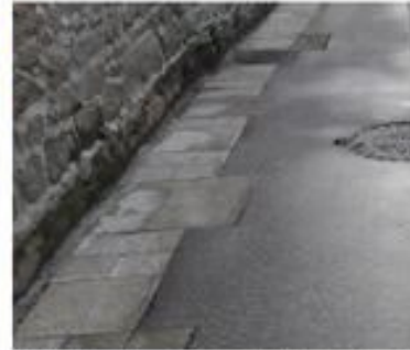
Dallettes et pavés multiformats granit à bords clivés, finition bouchardée, calepinage avec décalage, coloris gris-beige
