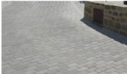
Pavés granit 10x14x ép. 12, bords clivés, finition bouchardée calepinage joints croisés, coloris gris-beige (place Radio Londres)
