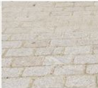
Pavés granit 10x14x ép. 12, bords clivés, finition bouchardée calepinage joints croisés, coloris gris-beige (place Radio Londres)
